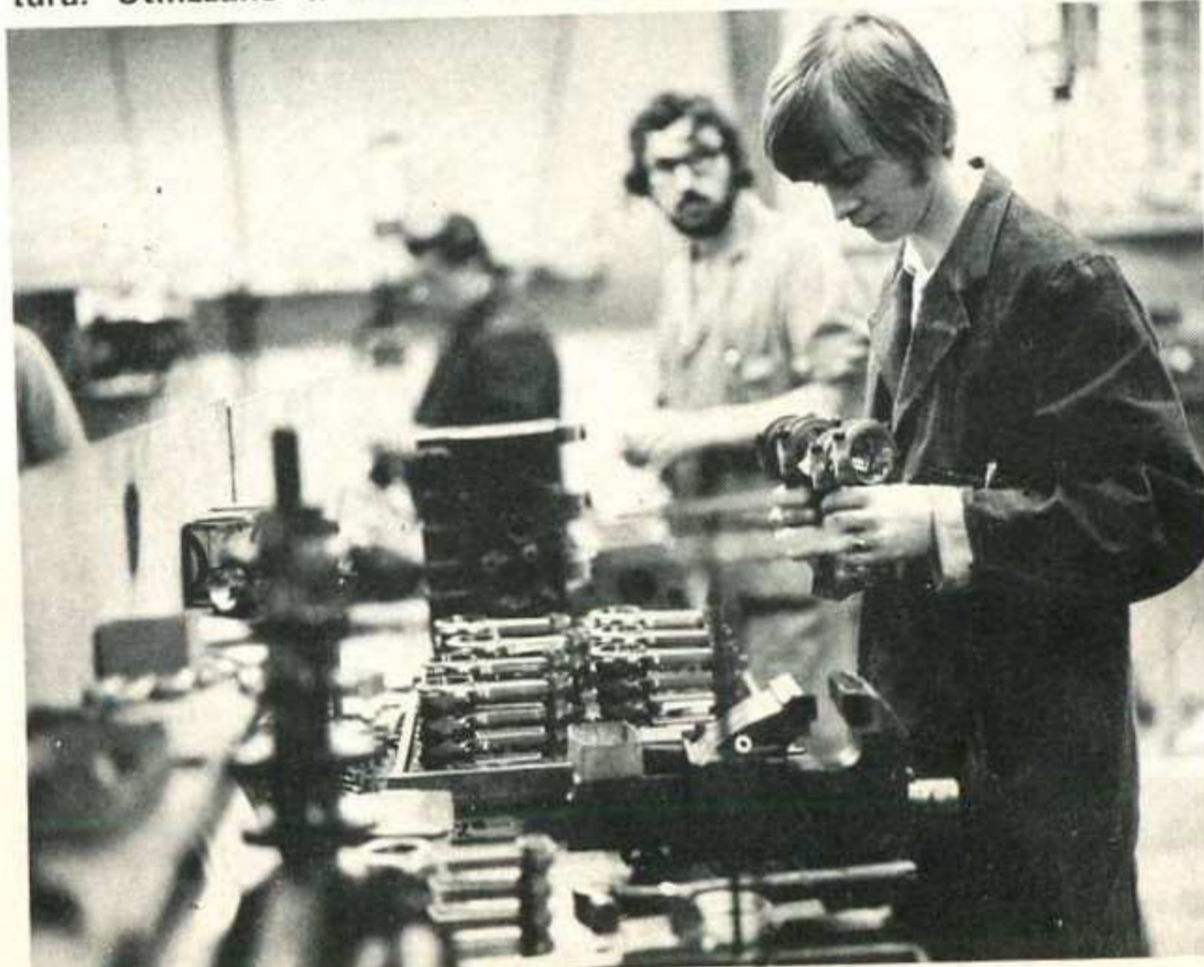
Una parte dei monoblocchi in lavorazione per la serie dei motori 1971. Ne costruiranno subito 16, poi forse un'altra diecina. Non di più. La scelta delle bielle (sotto), per misurazione e bilanciatura. Utilizzano il titanio, ma sperimentano anche altri materiali
